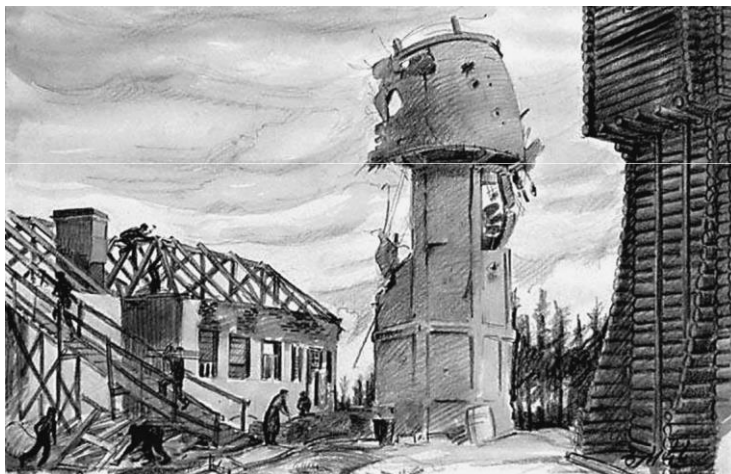
Медведев. «Водонапорная башня в городе Лодейное Поле»
